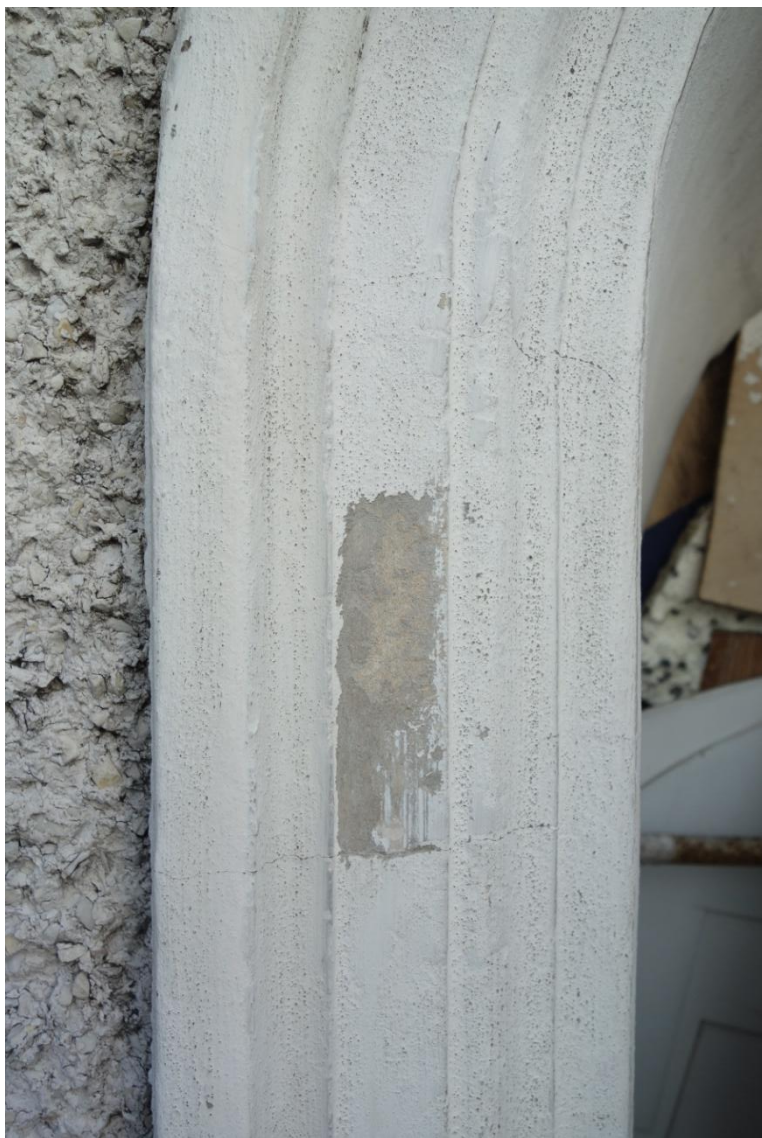
Fot. 14. Oprawa wnęki z figurą Matki Bożej z Lourdes – profil ciągniony z zaprawy barwionej w masie, starszej w kolorze jasnopiaskowym.
