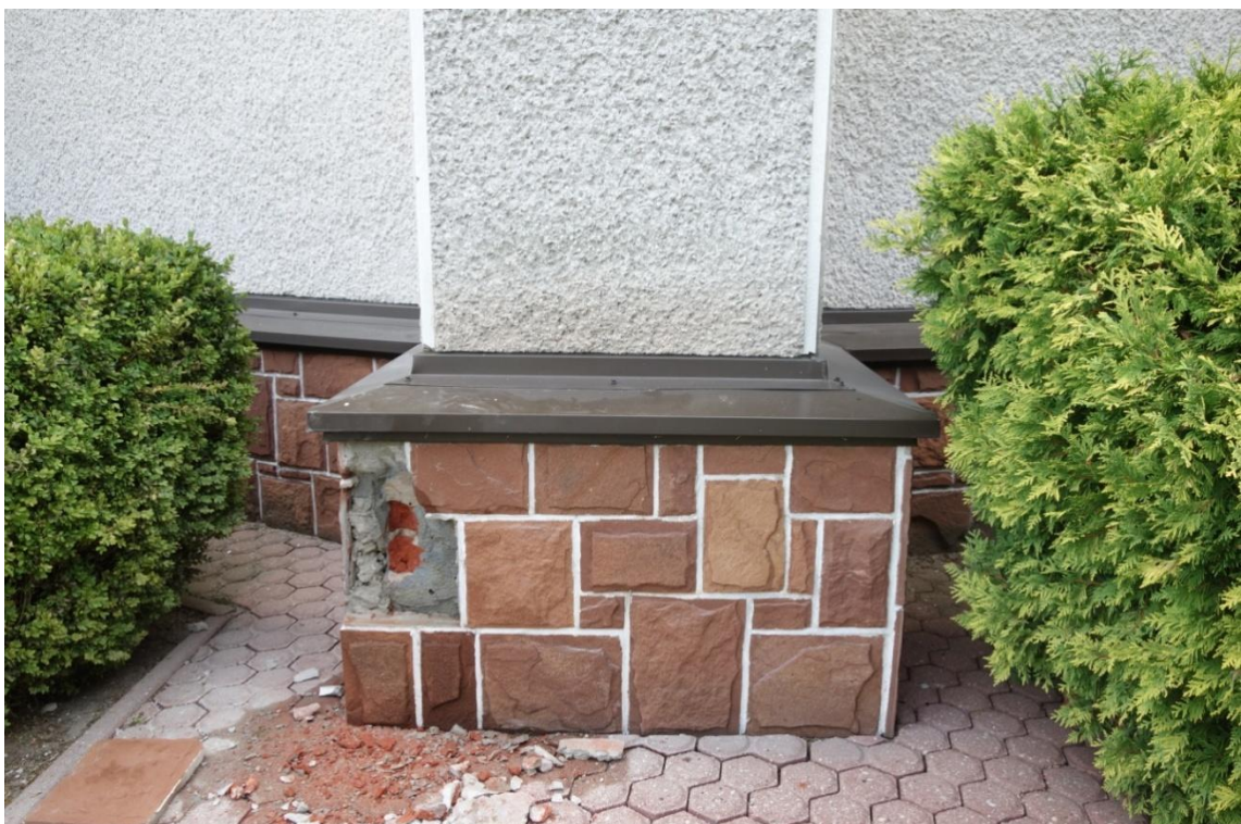
Fot. 25. Odkrywka budowy cokołu na przyporze prezbiterium. Fot. H. Granek - Smarzewska
