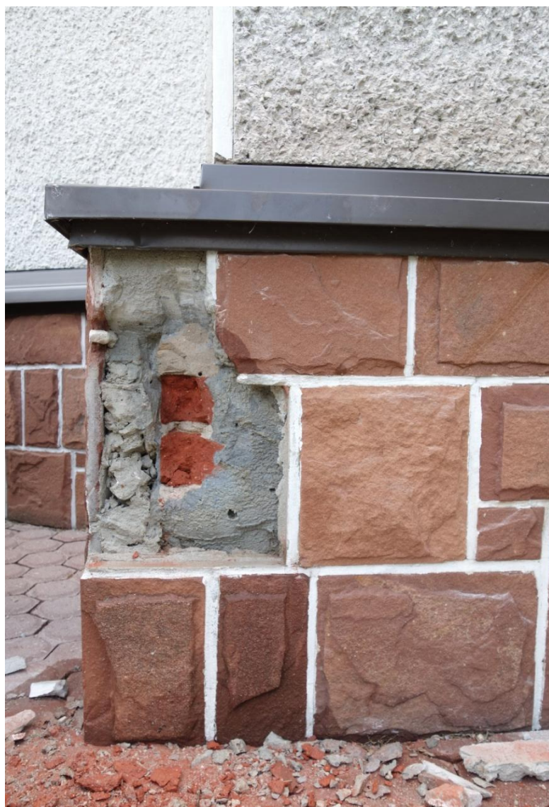
Fot. 26. Zbliżenie odkrytki budowy cokołu. Podłoże ceglane, partia tynku nakrapianego niezachowana, na występie pozostałości profilowania z zapraw powierzchniowo barwionych w masie w kolorze piaskowym, na podłożu ceglanym gruba warstwa zaprawy cementowej, do montażu okładziny z czerwonego piaskowca.
