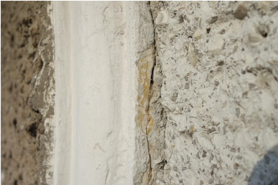
Fot. 6. Zbliżenie reliktyw opracowania malarskiego w kolorze żółci na profilowanym obramieniu okrągłej zdobiny umieszczonej w centrum płyciny poziomej nad wejściem głównym.
