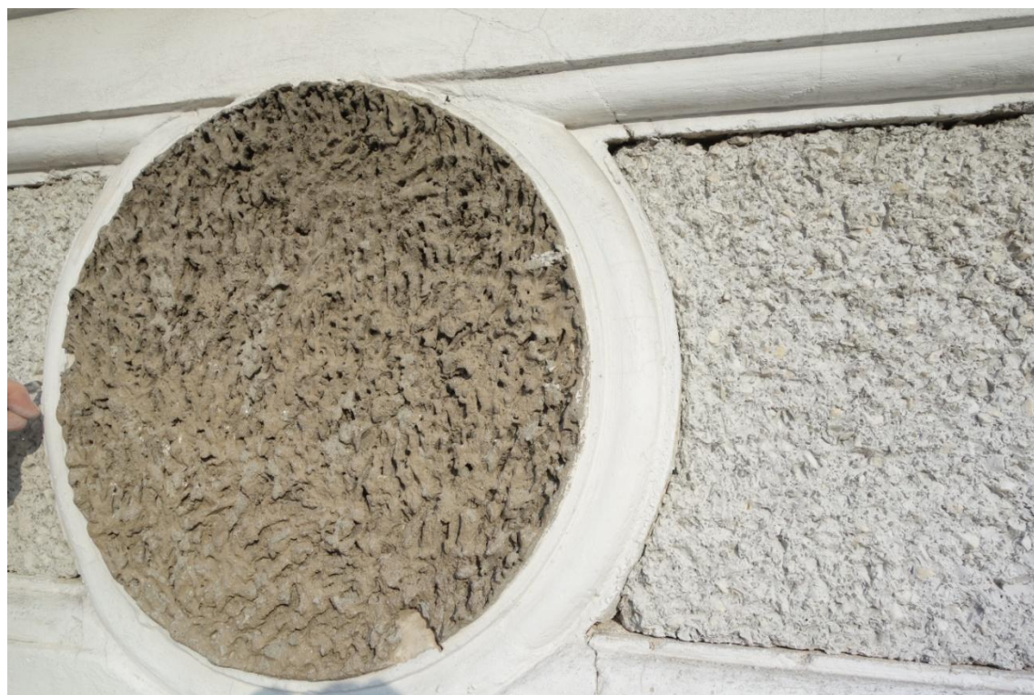
Fot. 5. Detal płyciny poziomej nad wejściem głównym, wypełnienie z tynku barwionego w masie w kolorze brunatno – szarym wykonany w technice nakrapiania. Fot. H. Granek - Smarzewska
