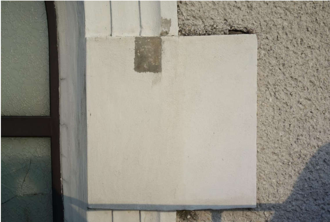
Fot. 10. Oprawa okna nad wejściem głównym, stylizowany kliniec boczny, prawy w widoku na wprost – zaprawa barwiona w masie w kolorze jasnopiaskowym, wyprawy starsze. Fot. H. Granek - Smarzewska
