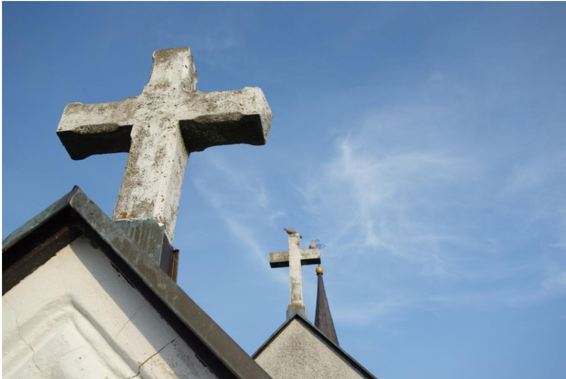
Fot. 17. Szczyt fasady kościoła z krzyżem wieńczącym. Nie określono materiału z przyczyn technicznych – wysokość poza zasięgiem zwyżki.
