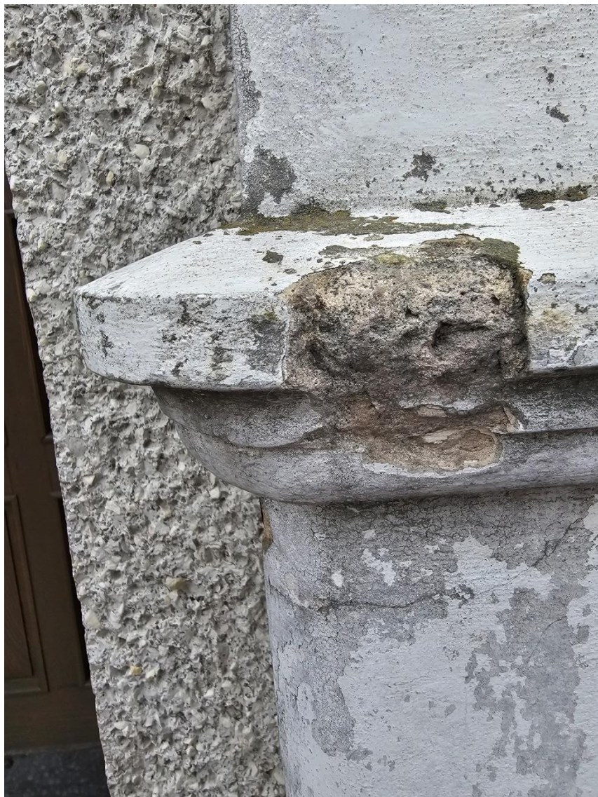
Fot. 16. Partia cokołowa portalu wejścia głównego, w ubytku do głębszej warstwy zaprawa w kolorze jasnopiaskowym, wyprawy starsze.
