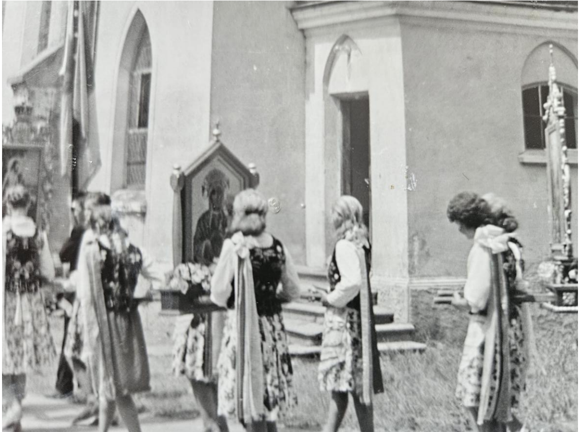
Fot. 27. Fotografia archiwalna uzyskana z zasobów ks. Proboszcza. Widoczne wcześniejsze, niezachowane opracowanie partii cokołowej kościoła tynkiem nakrapianym z miotły ? z ozdobnym profilowanym gzymsem w miejscu uskoku.
