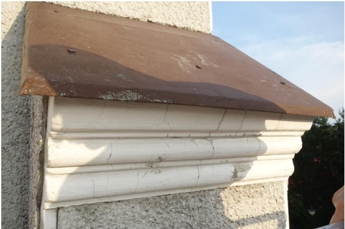
Fot. 21. Przypora prawa w widoku na wprost – zaprawy profili ciągnionych późniejsze, w kolorze szarym.
