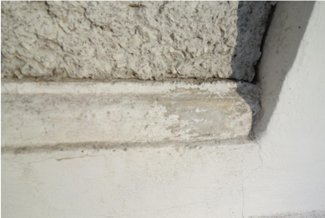
Fot. 8. Zbliżenie odlewanego profilu zamocowanego w płycinie poziomej nad wejściem głównym, zaprawa barwiona w masie w kolorze jasnopsiaskowym, wyprawy starsze. Fot. H. Granek - Smarzewska
