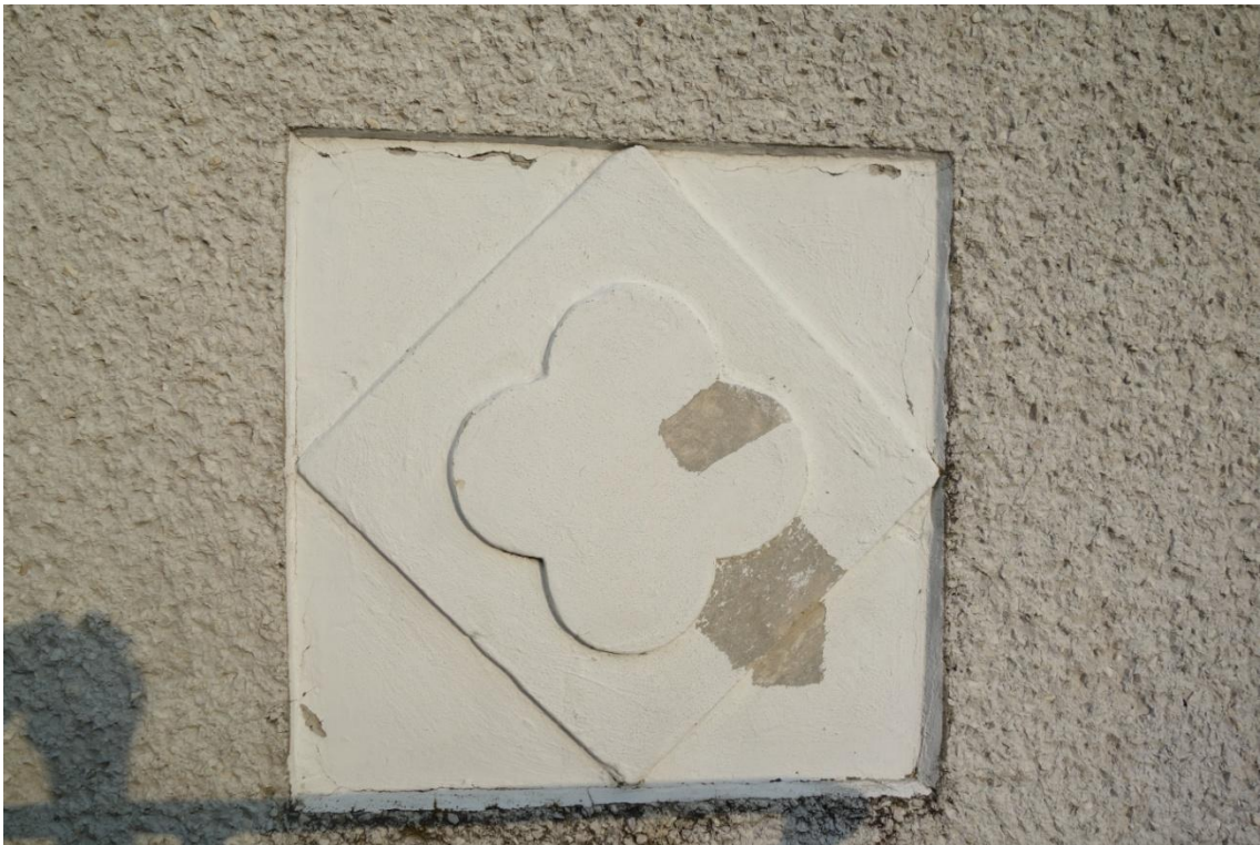
Fot. 9. Zdobina na wysokości okna powyżej wejścia głównego, po prawo w widoku na wprost – odlew wykonany z zapraw barwionych w masie w kolorze jasnopsiaskowym, wyprawy starsze. Fot. H. Granek - Smarzewska
