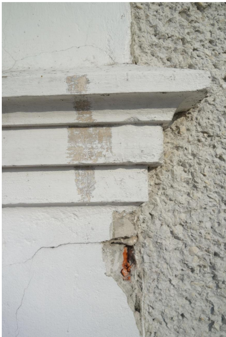
Fot. 1. Gzyms portalu wejścia głównego, wyprawy starsze w kolorze jasnopskowanym. Fot. H. Granek - Smarzewska
