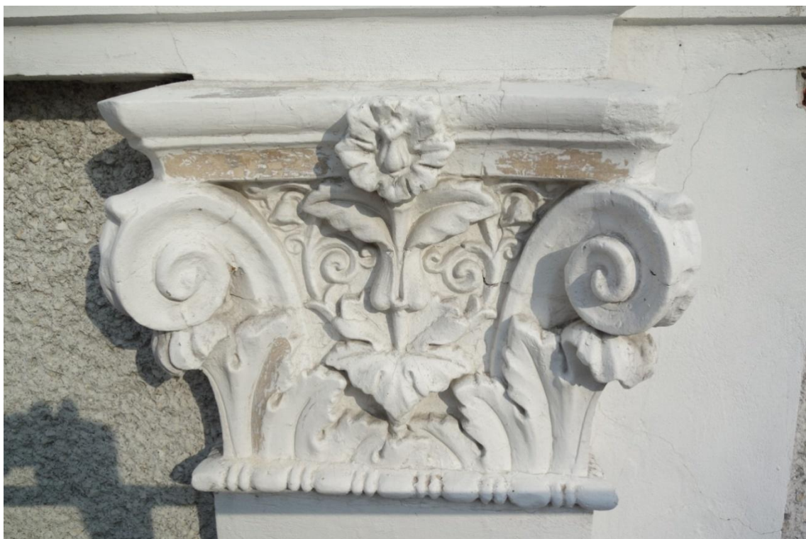
Fot. 4. Kapitel pilastru portalu wejścia głównego, odlew z zapraw barwionych w masie w kolorze jasnopiaskowym, zaprawy starsze. Fot. H. Granek - Smarzewska
